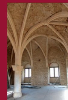
Letztes Stockwerk mit gotischer Wölbung
